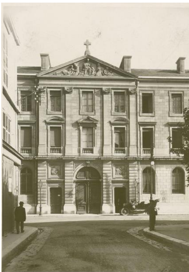
Figure 4. Grenoble. Façade de l'ancien Hôpital Mixte (section civile) après les travaux de 1864. Coll. BMG, Pd.4 (426), photographie anonyme, 1910-1920.
