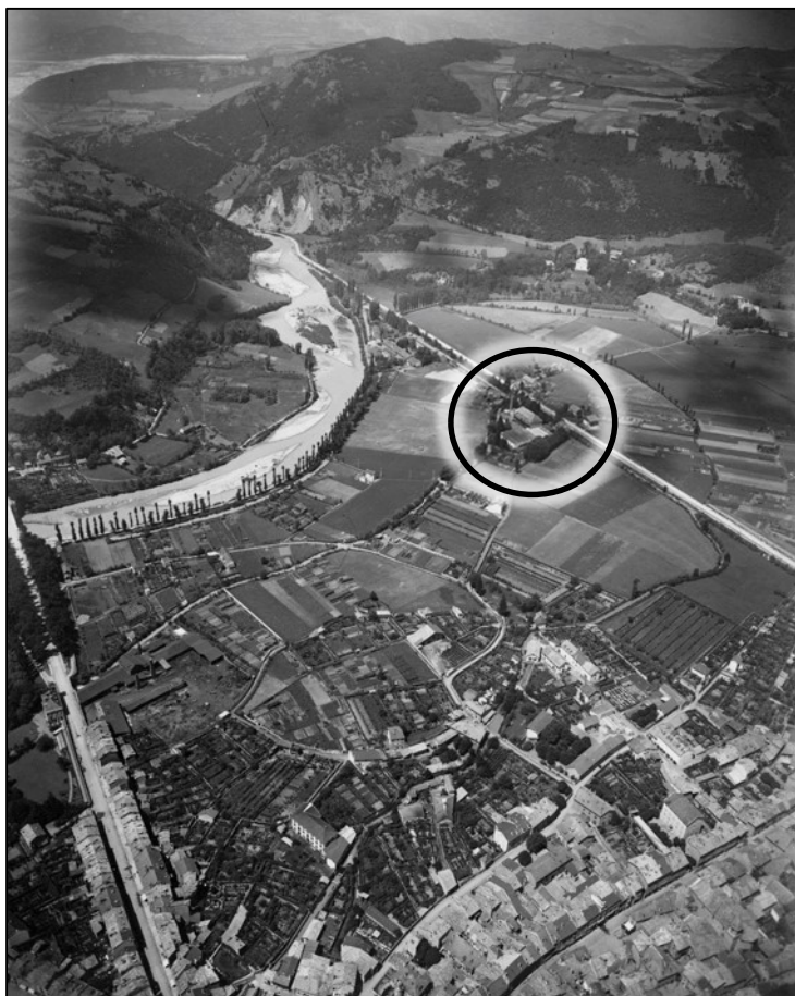
Figure 18. Vue aérienne de Vizille. L'usine de l'Alliance Textile est visible le long de la Route Imperial, A.Michel, 1907-1910, MD F72.182.
