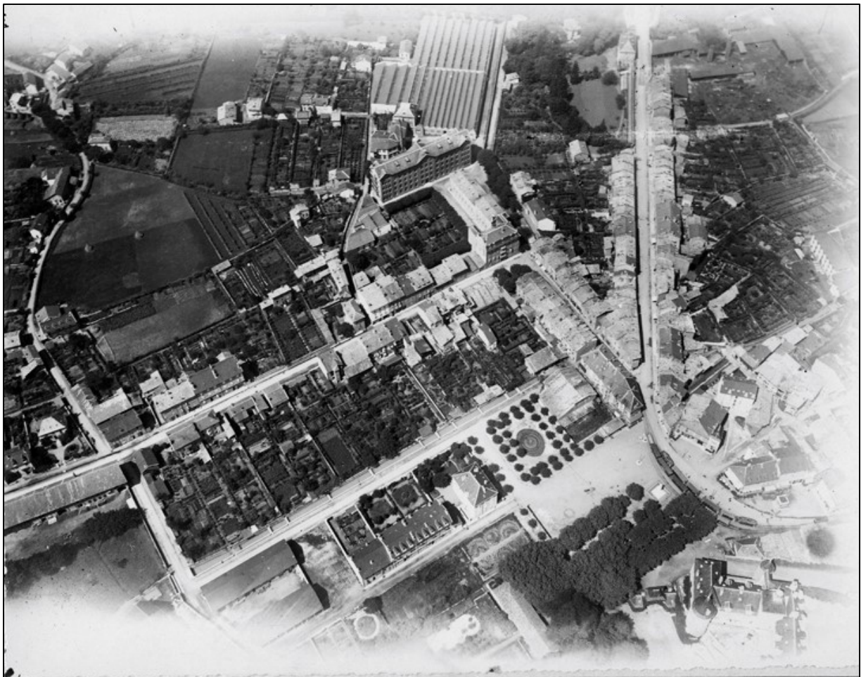
Figure 10. Vue aérienne du centre-ville de Vizille. Les Usines Bellon (devenue Tresca puis Tissage de Vizille) sont identifiables par les grands ensembles en haut de la photographie. Le château apparaît en bas à droite. MD F72.191, Photographie argentique, R.Tomitch, Vue aérienne de Vizille, 1910-1925.
